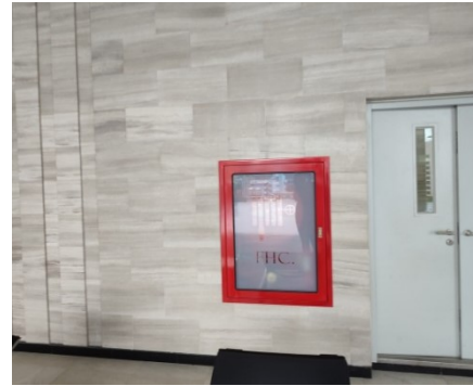
ตู้เก็บสายฉีดน้ำดับเพลิง และไฟฟ้าส่องสว่างฉุกเฉิน
