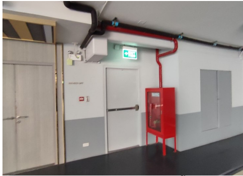
ตู้เก็บสายฉีดน้ำดับเพลิง และไฟฟ้าส่องสว่างฉุกเฉิน
