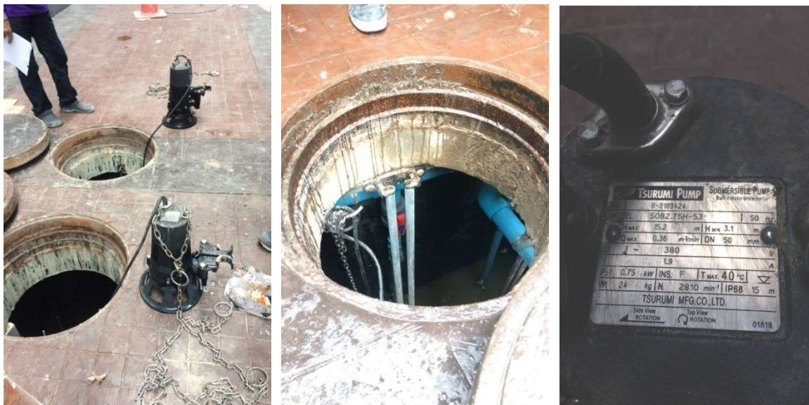
5-45 Submersible Pump ใช้จริง 1 ชุดและสำรองไว้ 1 ชุด (Sparepart)
