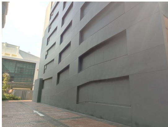
ภาพที่ 5-51 ปรับปรุงผนังอาคารจอร์จด้านทิศใต้ของอาคาร เป็นผนังกันเสียง ปิดทับป้องกันผลกระทบด้านเสียงจากอาคารจอร์จ ไปยังอาคาร ฟิเอสเจ อพาร์ทเมนต์ และอาคาร โรงแรม คราวน์ บีทีเอส นานา
