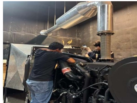
ภาพที่ 5-3 ห้องเครื่องไฟฟ้าสำรอง ดูแลตรวจสอบ และทดสอบให้อยู่ในสภาพดีพร้อมใช้งาน
